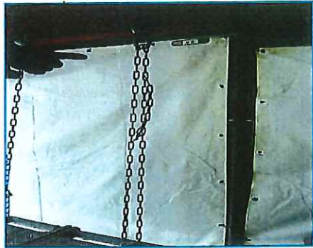
吊金具にループ掛けの施工
