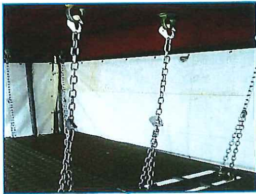
吊金具にシングル掛けの施工
